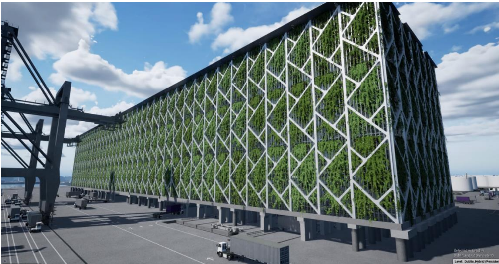
Abb. 13: Mögliche Verkleidung mit einer Greenwall
