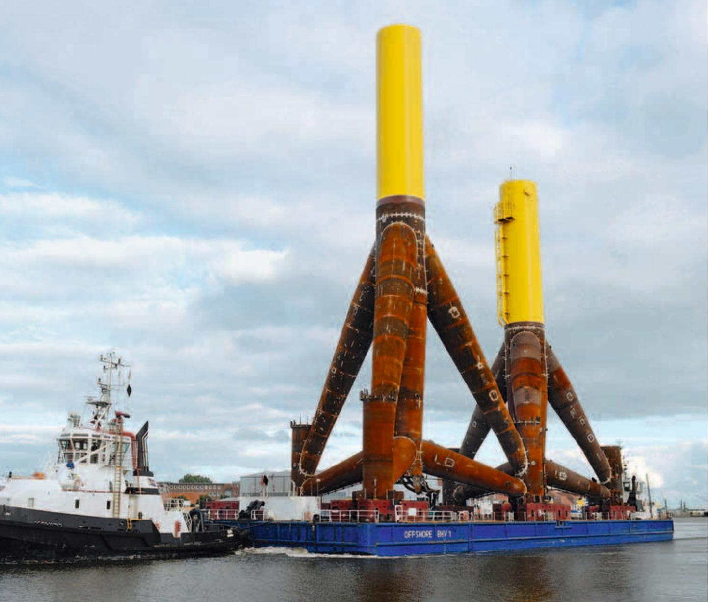
Alle zehn Tage werden zwei Tripoden à 900 Tonnen fertiggestellt, die jeweils im Päckchen auf den spezialangefertigten Ponton verladen werden. Der Ponton dient als Shuttle zwischen der WeserWind-Produktionsstätte im Offshore-Windport Bremerhaven (Labradorhafen) und dem fünf Kilometer entfernten Offshore-Terminal ABC-Halbinsel, wo die Windradkomponenten zwischengelagert werden. Einen imposanten Eindruck von den Umschlag­tätigkeiten am dortigen Terminal vermittelt das Titelbild.
