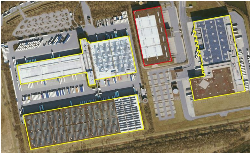
Abbildung 2.5: Beispiel aus Hamburg, das die unterschiedlichen Erscheinungsformen von Photovoltaik auf Hallen zeigt.
